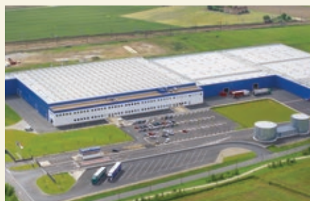
> Panneaux rayonnants eau chaude, Delipapier Ingrandes/ Vienne
