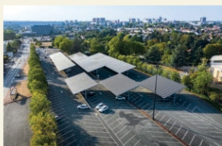
> Ombrières sur parking, Poitiers
